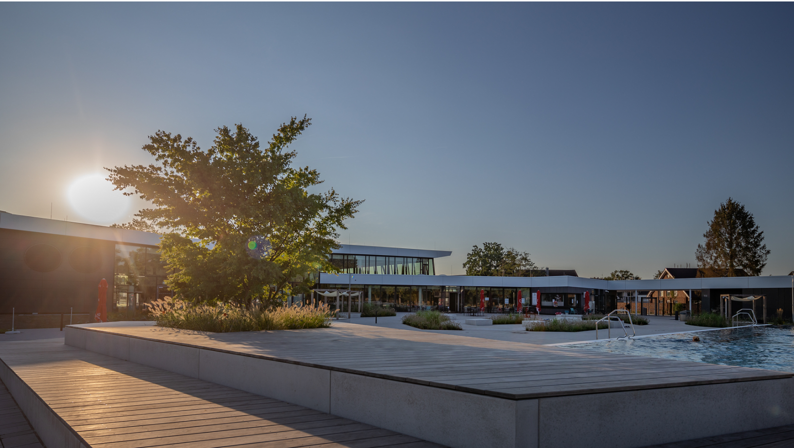
Neues Freibad mit attraktiven Holzelementen aus Kebony
